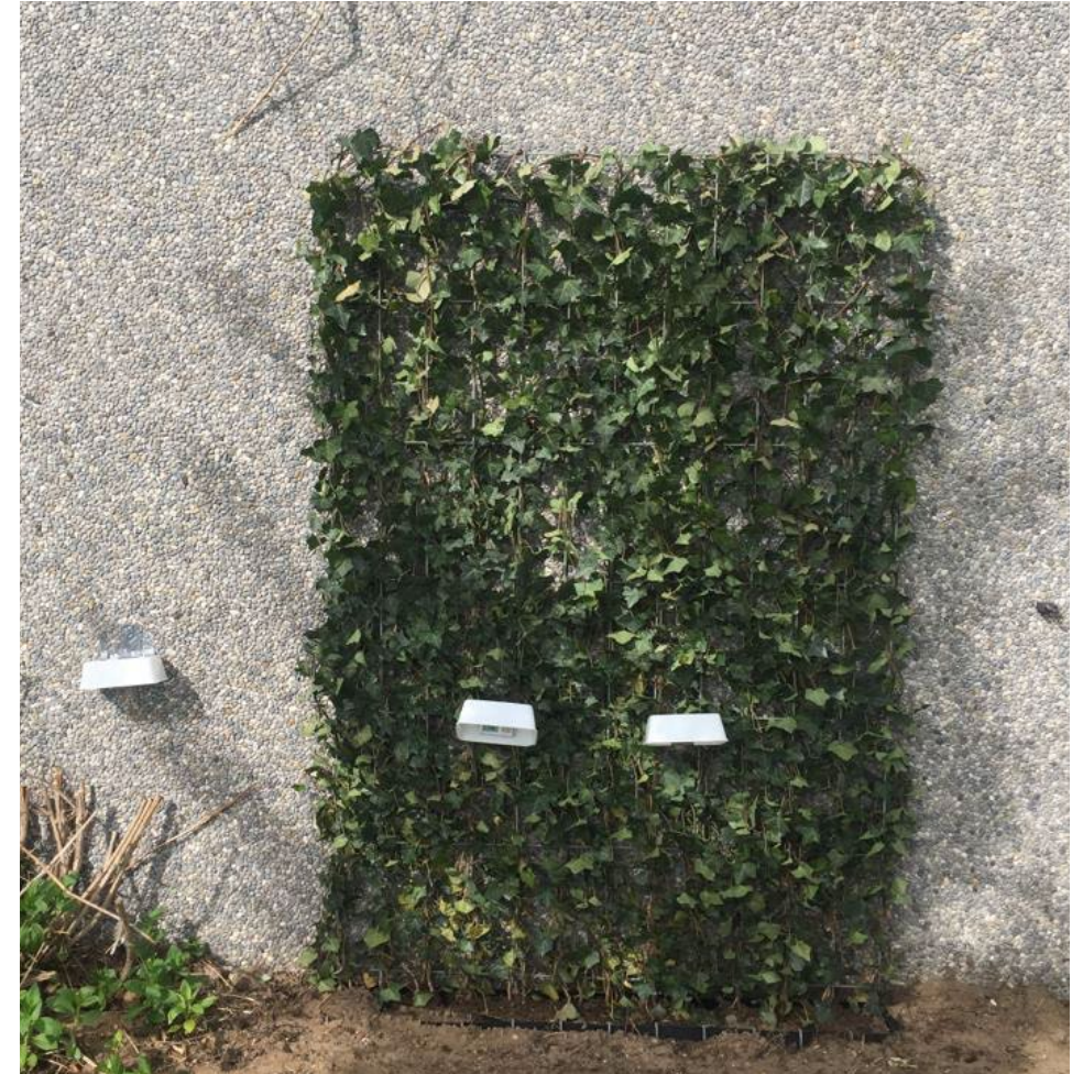
In situ meting warmtedoorgangscoefficient
