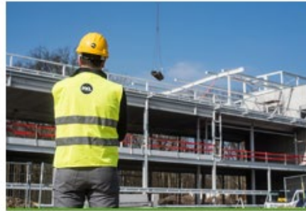
PXL BOUW EN ENERGIE
